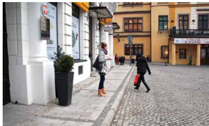
Estetyczny chodnik na Rynku po remoncie.
